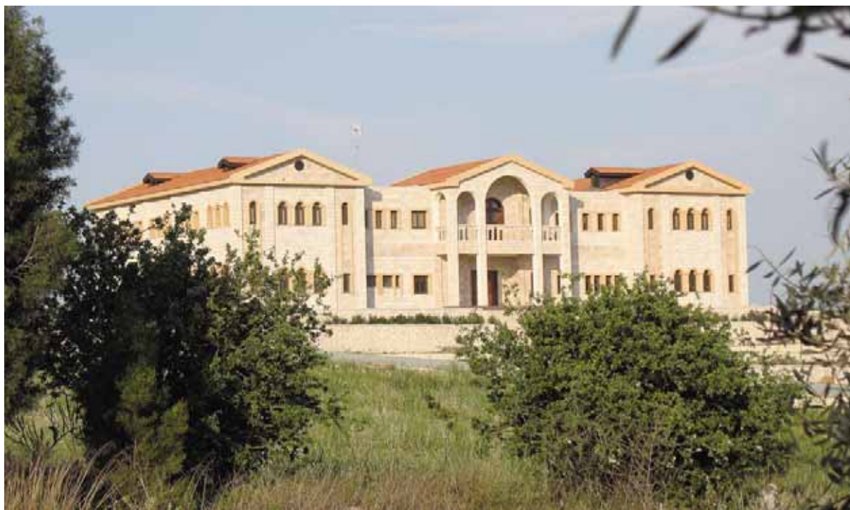
Αποψη του μετοχίου του Προφήτη Ηλία στον Κοισιάτη.
