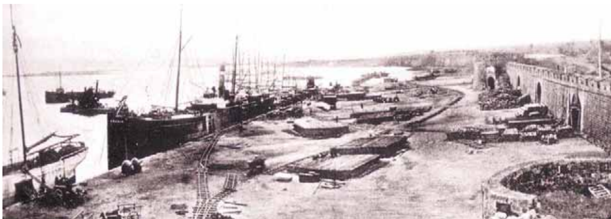
Σιδηροδρομικό υλικό ξεφορτώνεται στο λιμάνι της Αμμοχώστου.
