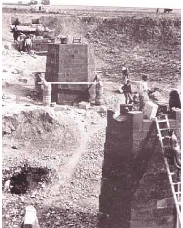
Κτίσιμο γέφυρας για το Σιδηρόδρομο στη Μια Μηλιά (1904)
